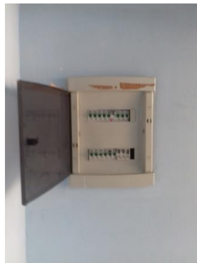
sekundarna razvodna ploča
